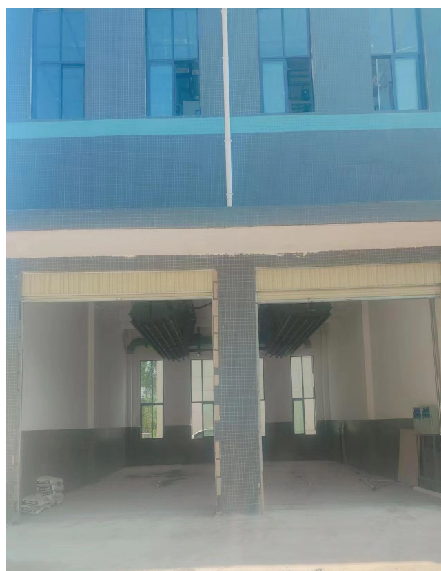
一般固废暂存间
