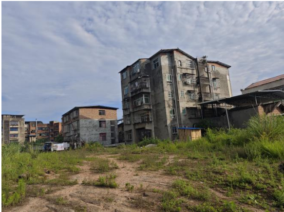
南侧外环境（居民区）
