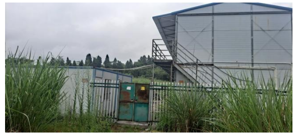
地块内北侧（临时建筑）
