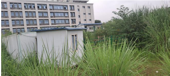
地块内北侧（临时建筑）
