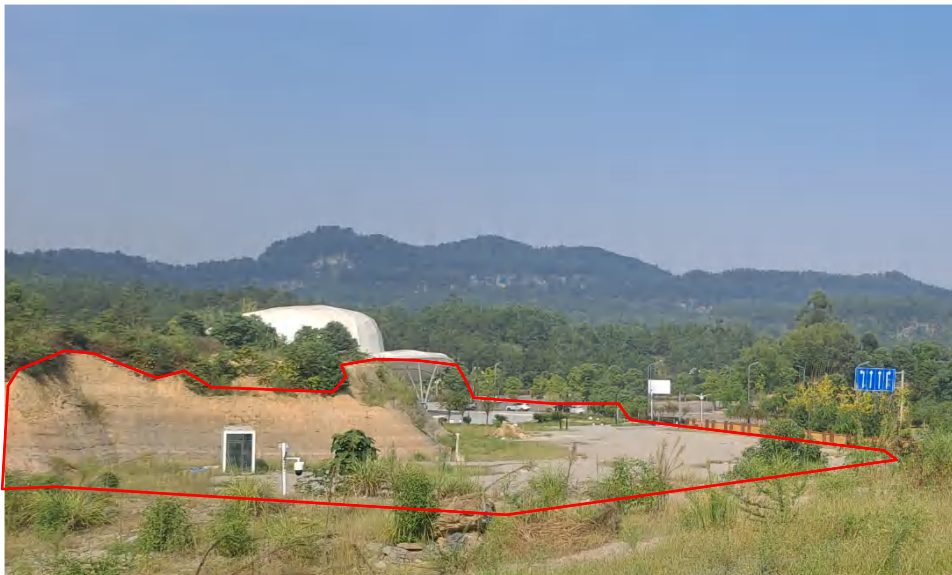
图 5-3 地块外挖方区
