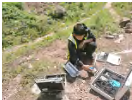
W3 现场检测
