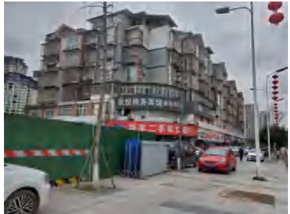
北侧外环境-商铺
