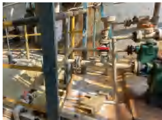
40kt/aF22 装置的废碱收集池（2 处）运输机泵
