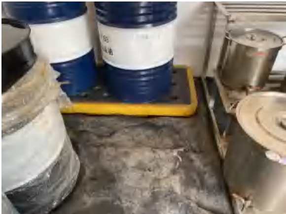
二氟一氯甲烷生产线润滑油间（40kt/aF22 装置），防渗膜有破损
