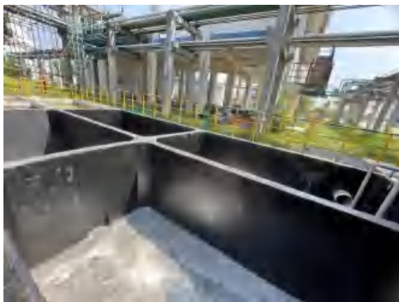
事故应急池（位于 F142b 生产装置）
