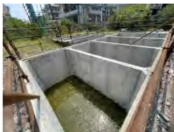
5000 吨悬浮树脂装置冷却水收集池
