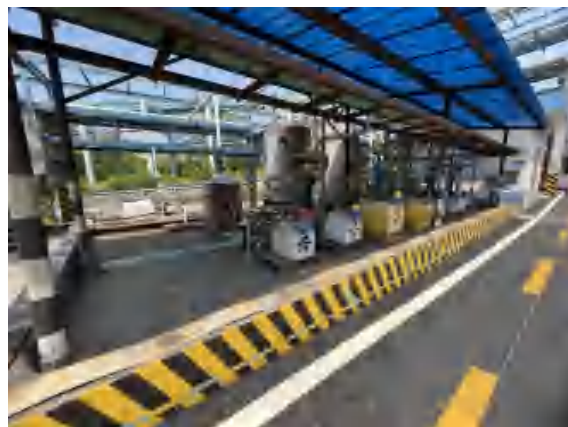
16kt/aF22 装置盐酸循环槽区运输机泵
