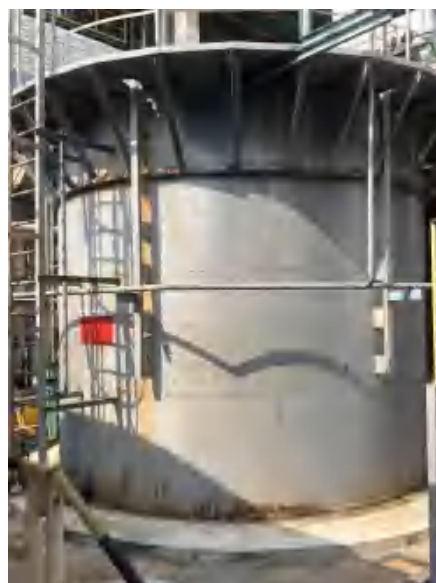
40kt/a F22 装置中和液贮罐及围堰
