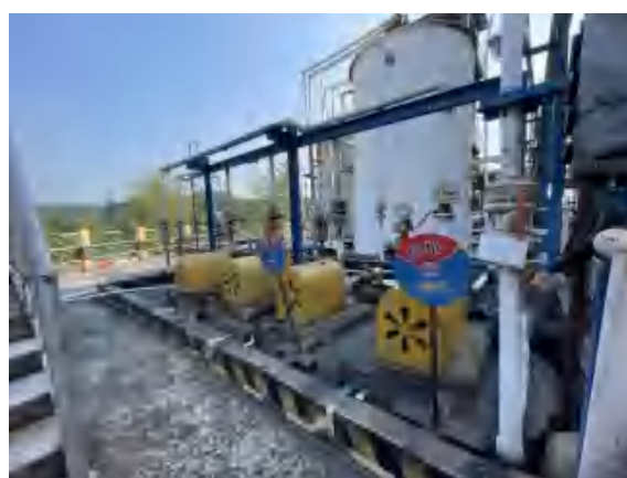
等离子裂解 HF 酸槽运输机泵
