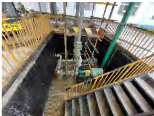
聚合氯化铝生产线污水收集池运输机泵
