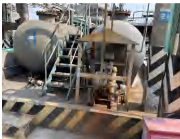
硅树脂生产线一苯基、二苯基槽区运输机泵
