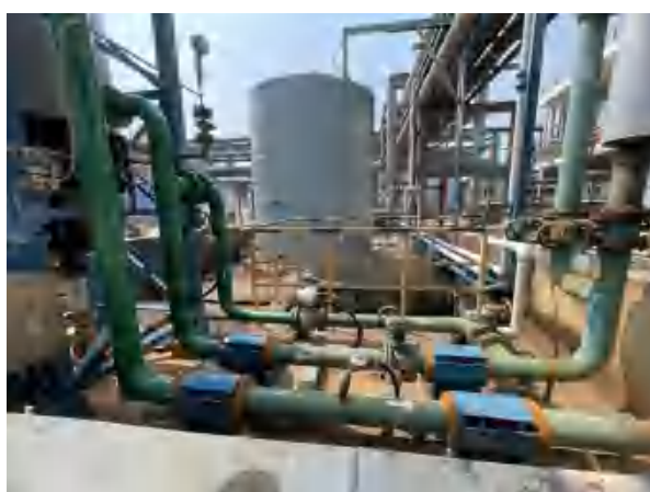
16kt/aF22 装置稀酸槽运输机泵
