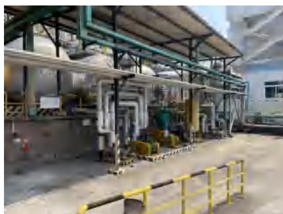
40kt/a F22 装置氯仿计量槽运输、F22 槽区运输机泵
