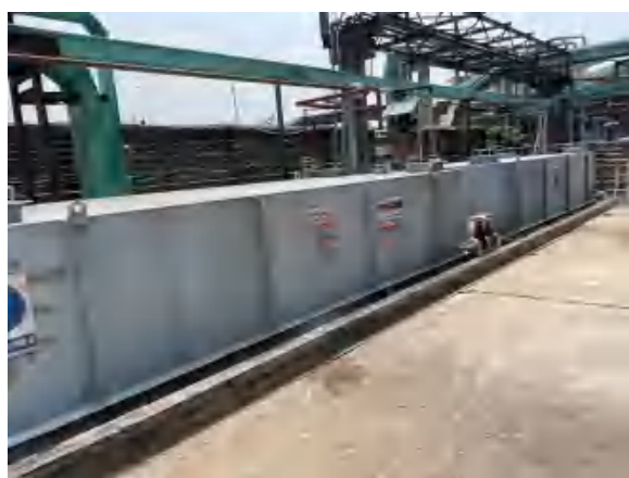
氟化三厂 9000t/a 四氟乙烯单体装置碱液槽及连接的事故池
