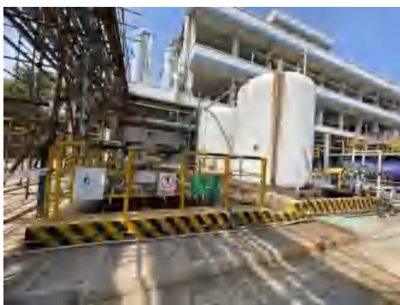
F142b 生产装置碱液槽区及配套收集池
