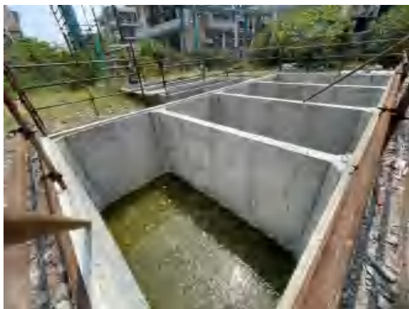
氟化三厂 12000t/a 四氟乙烯单体装置脱水岗位事故应急池
