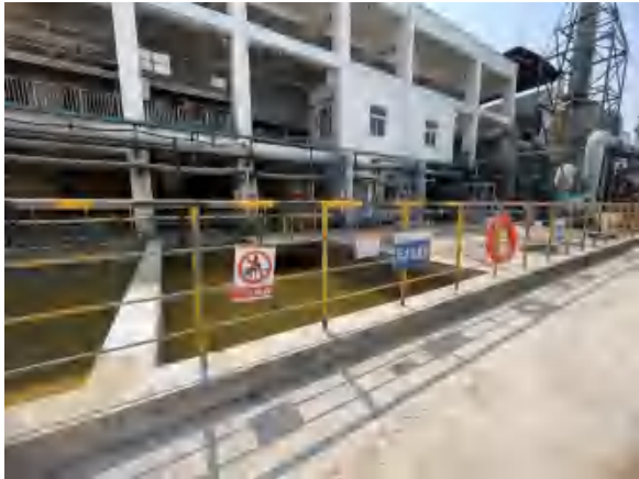
聚合氯化铝生产线污水收集池
