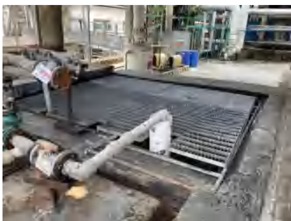
硅树脂生产线有机硅厂环保处理池（碱液池）
