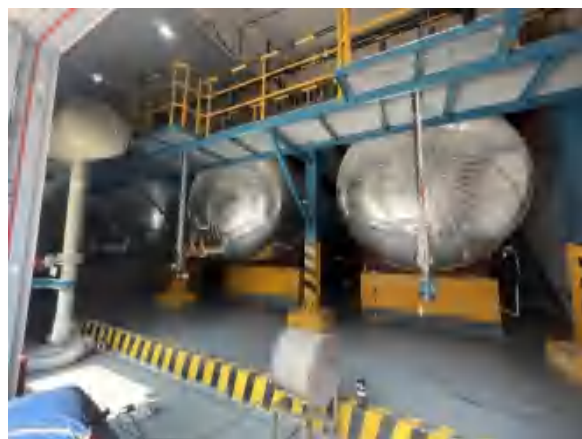
F142b 生产装置氟化二厂液氯槽区
