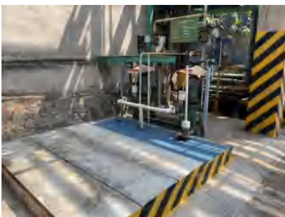
16kt/aF22 装置氯仿计量槽配套的收集池
