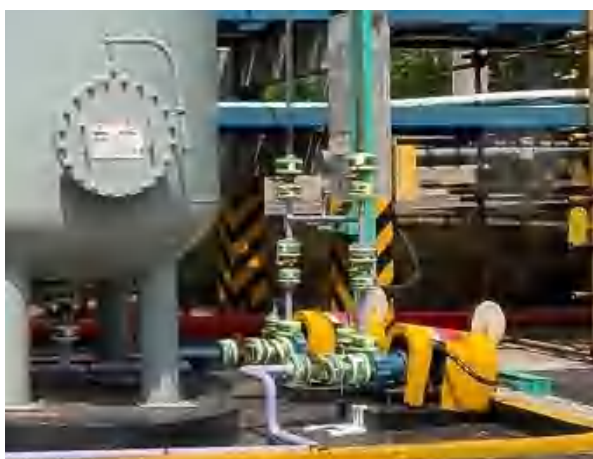
16kt/aF22 装置稀碱罐运输机泵
