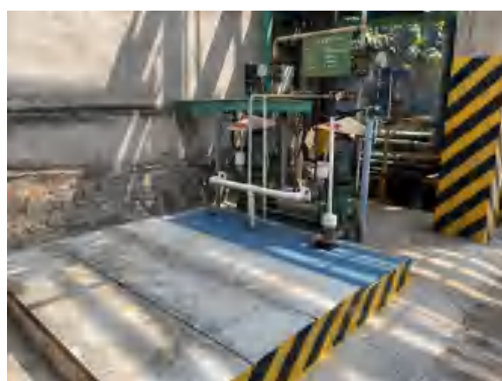
16kt/aF22 装置氯仿计量槽运输机泵
