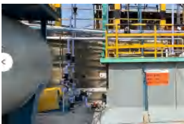
F23 焚烧炉碱液槽运输机泵
