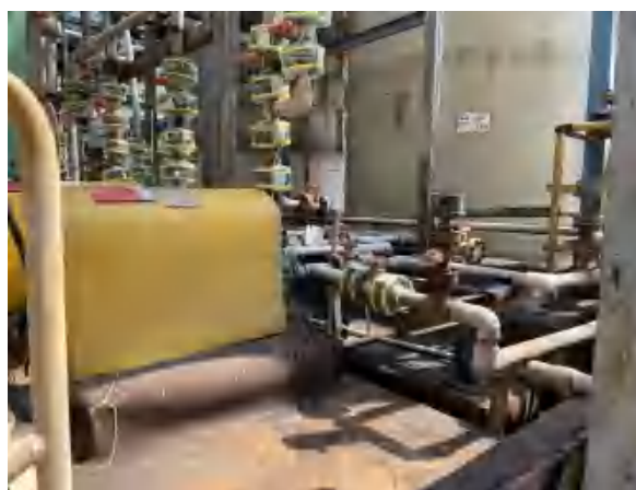
40kt/a F22 装置盐酸循环槽区运输机泵
