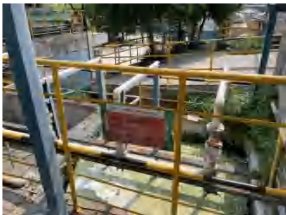
含氟废水处理站尾气洗涤循环池
