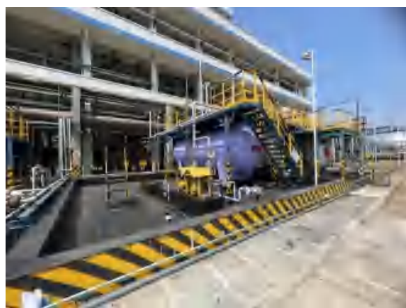
F142b 生产装置碱液槽区及配套收集池
