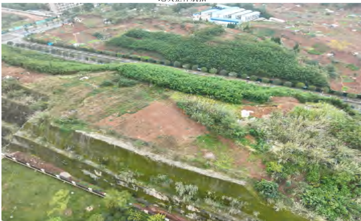
地块整体东侧硬化边坡
