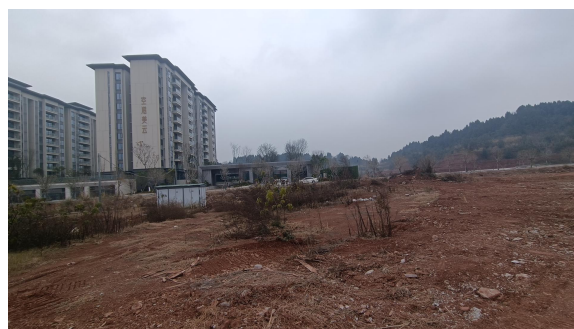
西侧外环境（道路、空港美云项目）
