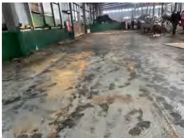
含油部件拆解区
