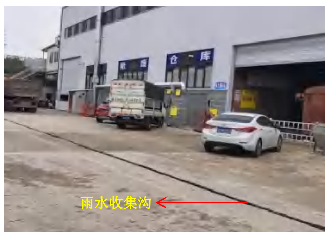
危废暂存区下游地面硬化情况（无裸露土壤）
