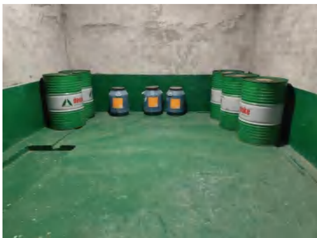
危废暂存区内地面硬化情况
