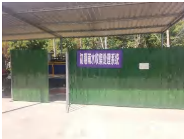
池体区（地下池体）
