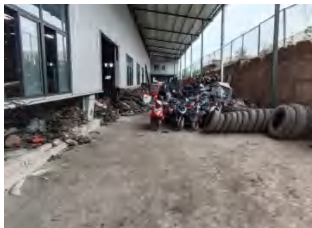
拆解车间下游（摩托车贮存区）地面硬化情况（无裸露土壤）
