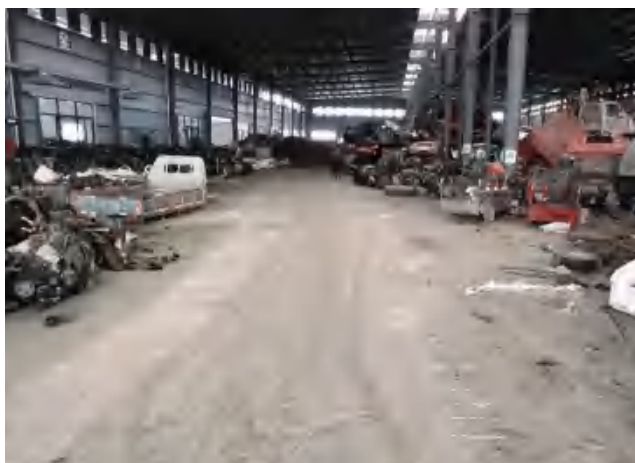
拆解车间（包含预处理区、拆解区、蓄电池拆解区、含油部件拆解区）内地面硬化情况
