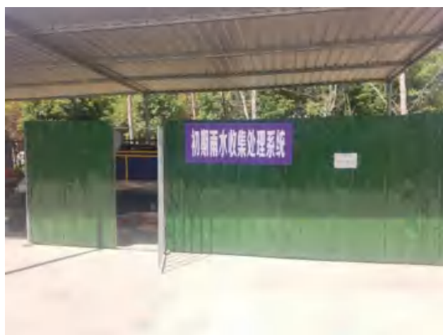
池体区下游地面硬化情况（无裸露土壤）
