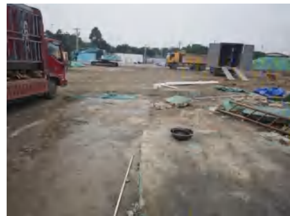
废气排气筒（2024 年 12 月）
