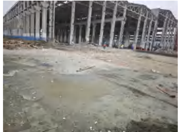
危废暂存间（2025 年 1 月）
