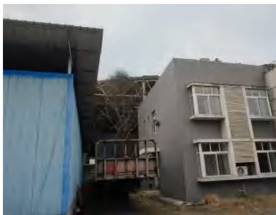
北侧外环境（特变电工（德阳）电缆股份有限公司）
