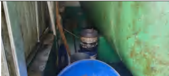
储罐区（地沟槽）
