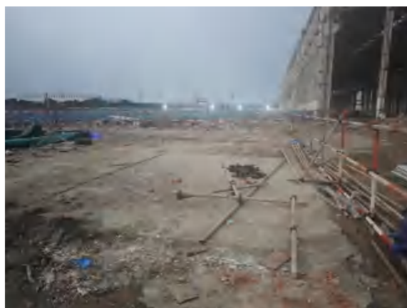
废机油装卸区（2025 年 1 月）
