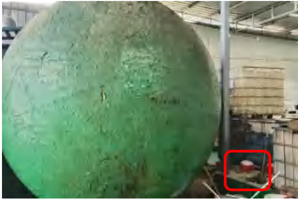
消防砂池（2024 年 8 月）
