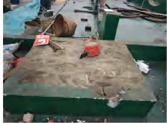
消防砂池（2025 年 1 月）
