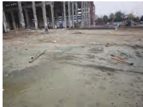
危废暂存间（2024 年 12 月）
