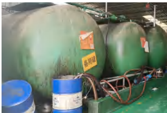
储罐区（储罐离地 30cm，2024 年 8 月）
