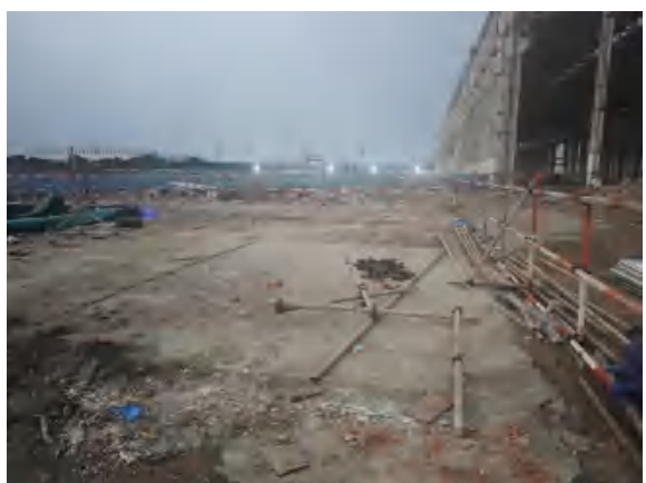
废机油装卸区（2024 年 12 月）
