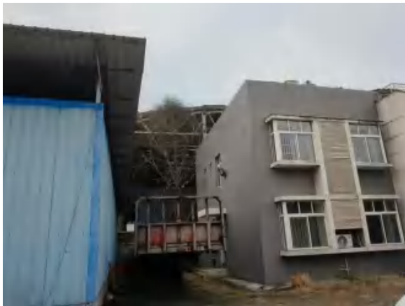
北侧外环境（特变电工（德阳）电缆股份有限公司）
