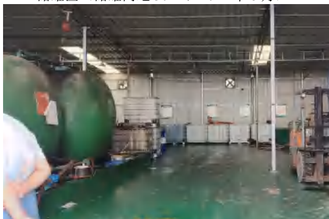
废机油装卸区（2024 年 8 月）
