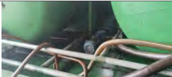
储罐区（地沟槽）
