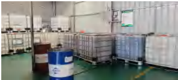
成品桶装润滑油储存区(地沟槽)
