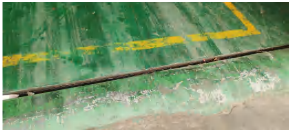
废机油装卸区(地沟槽)
