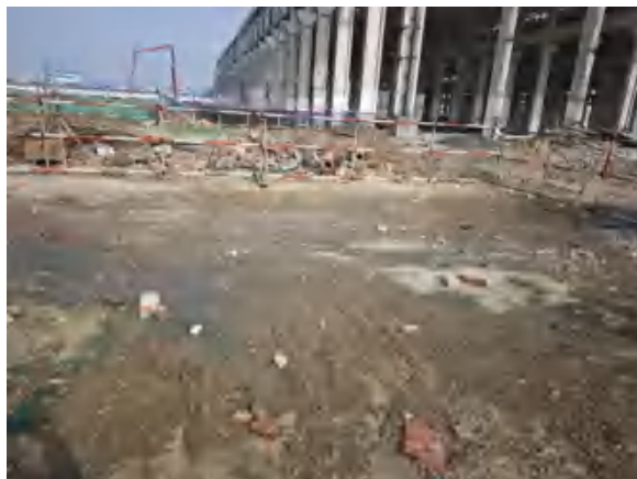
成品桶装润滑油储存区（2024 年 12 月）
