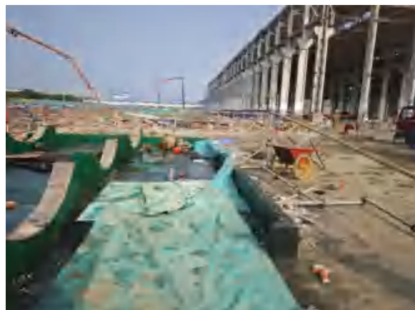
储罐区（储罐离地 30cm，2025 年 1 月）
