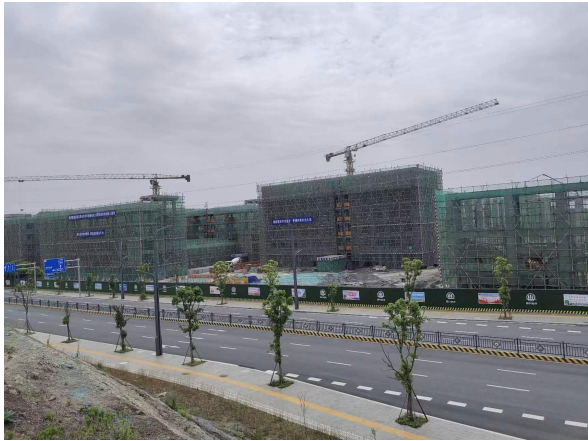
南侧外环境（道路及在建工程）
