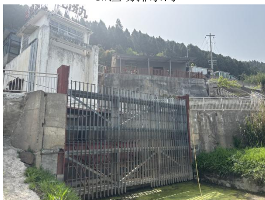
进水口现状（竖井、拦污栅、管理用房） 现状照片
