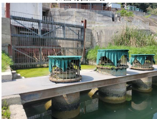
岸塔式进水口现状
