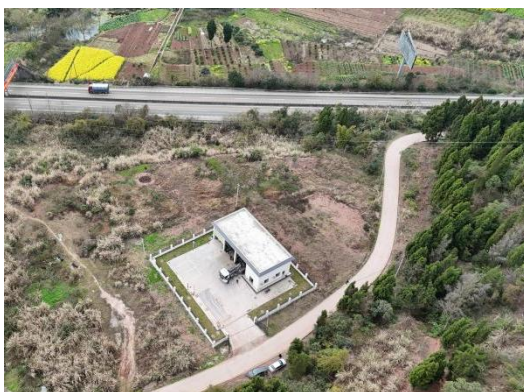
2#渣场植被恢复
