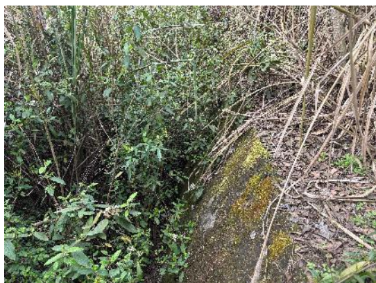
2#弃土场挡土墙
