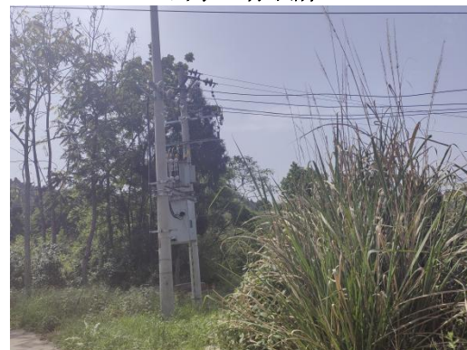
运营期植被恢复情况
