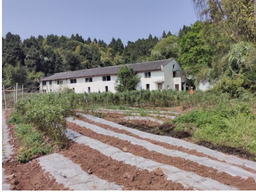
9#临时斜井植被恢复
