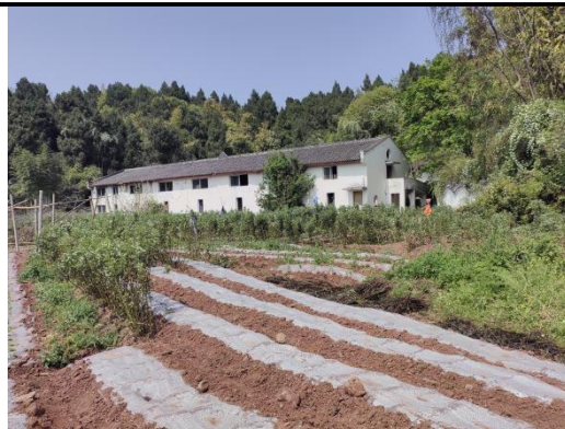
9#临时斜井植被恢复
