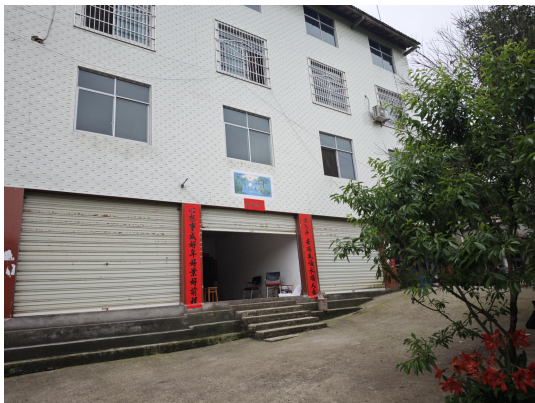
地块内东南侧民房
