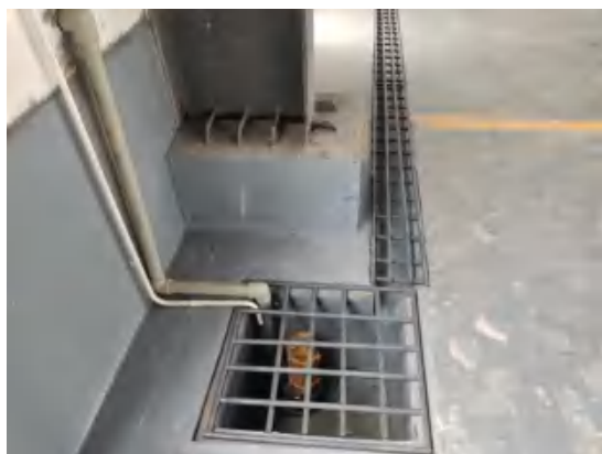
厂房内导流沟、收集池
