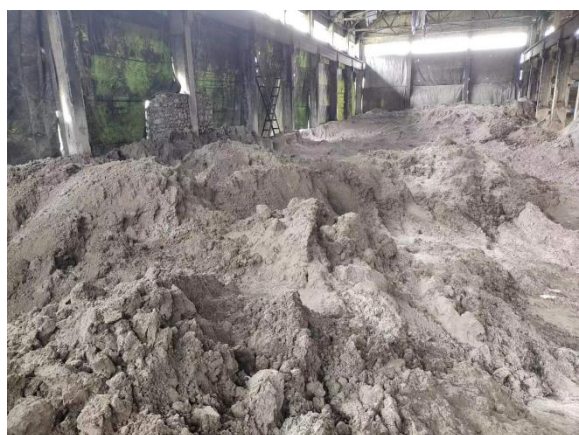
硫精砂库房内脱硫石膏
