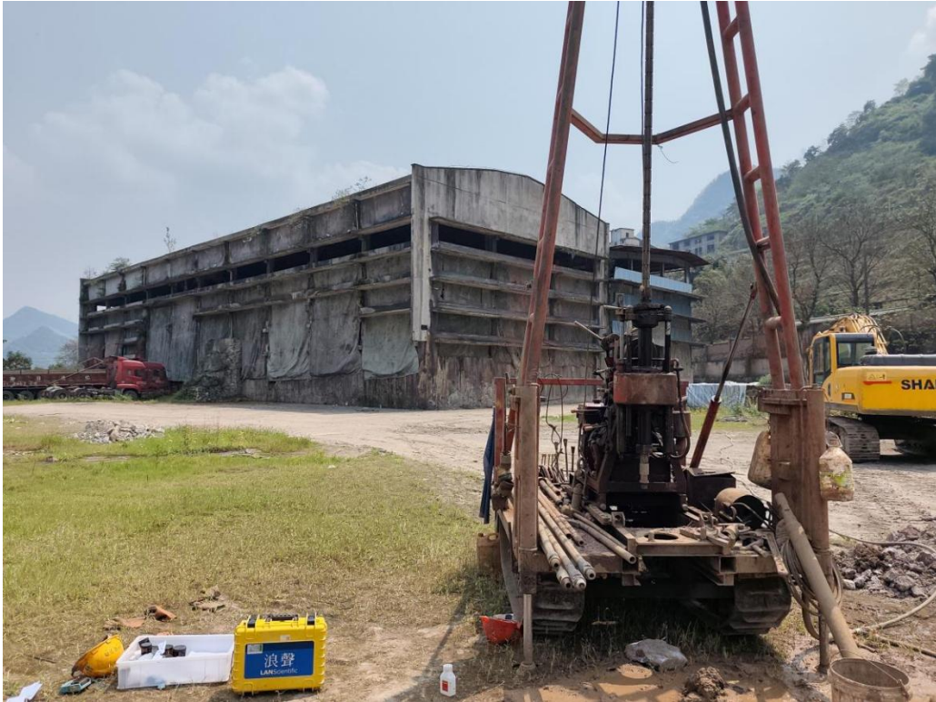
现场钻探照片
