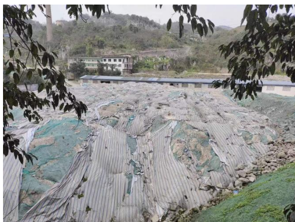
磷酸一铵生产区脱硫石膏清运前
