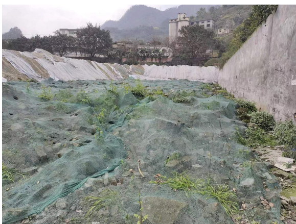
成品库房 2 拆除后的区域
