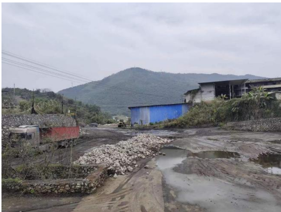
东侧外环境（S436 巡玉路项目废弃堆场）
