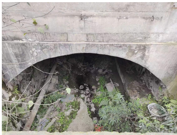
成品库房 1 下面排洪沟
