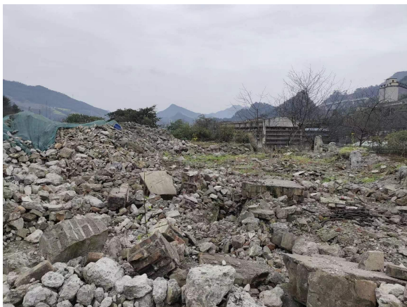
干吸区、转化区拆除后的空地
