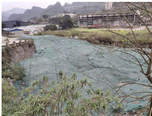
备品备件库、淋溶水收集池拆除后的区域
