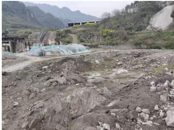
西侧外环境（石杰环保科技有限公司拆除后的空地）
