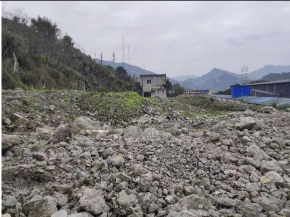
成品库房 3 和脱盐水车间区域建渣
