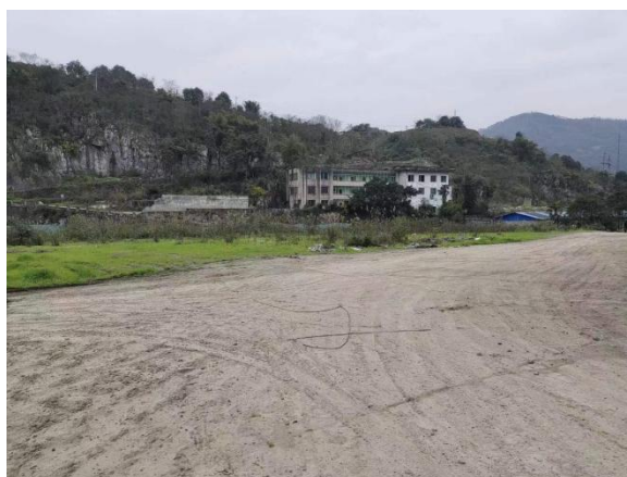
原料工段区、焙烧区、净化区
