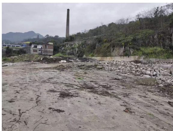
成品库房 3 拆除后的区域
