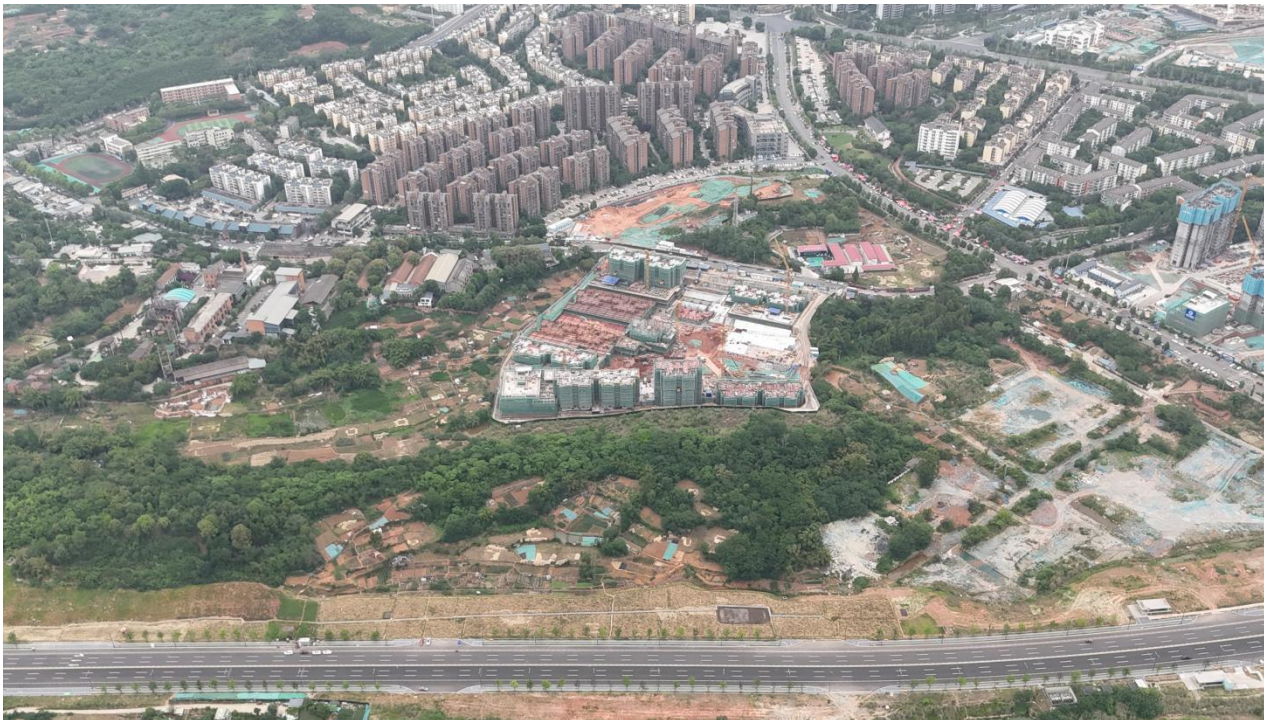
调查地块北侧（北侧紧邻福州路西段/地铁 6 号线，道路以北为未利用地和农用地）
