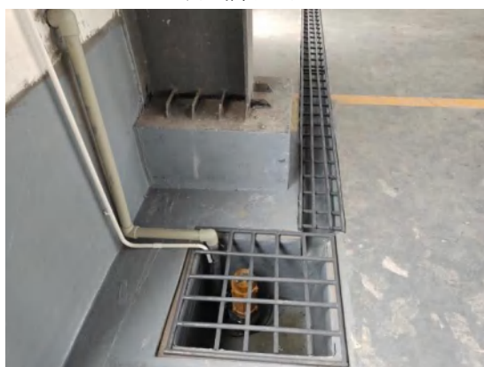
厂房内导流沟、收集池
