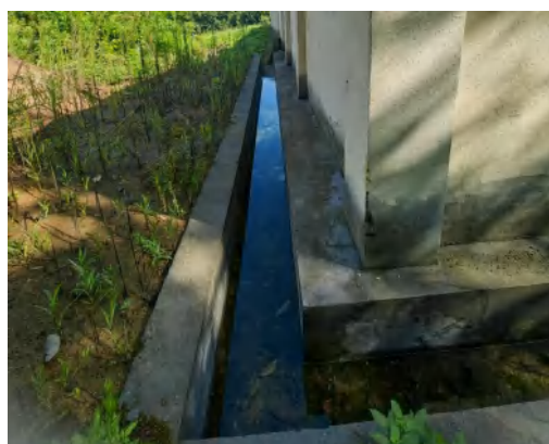
变电站排水沟
