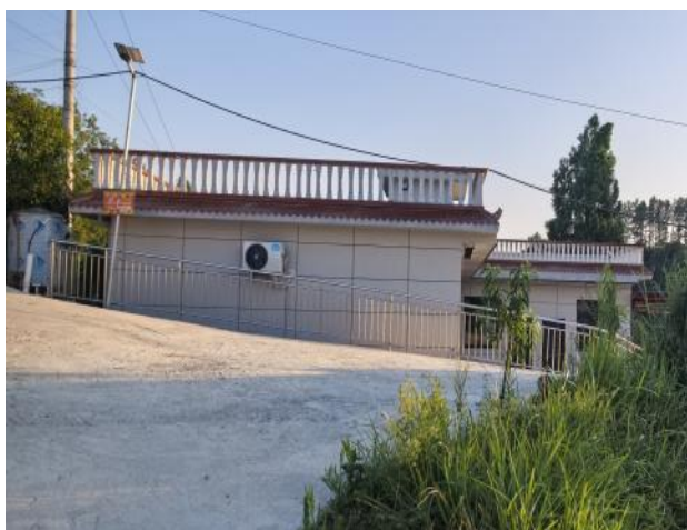
地块内南侧居民点
