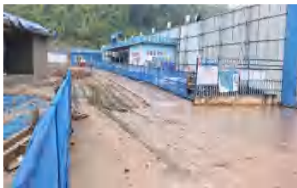
地块内西侧在建工程临时办公区
