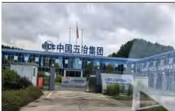
地块外东侧中国五冶集团临时项目部
