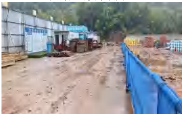
地块内西侧在建工程临时办公区
