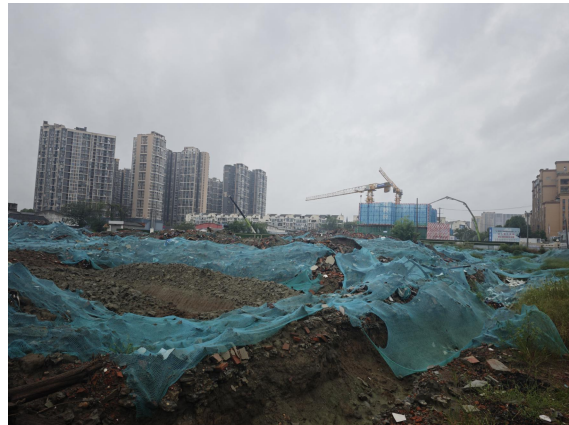
华阳木制厂库房（2025 年 8 月）
