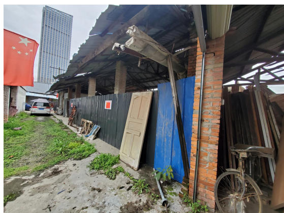
华阳木制厂库房（2025 年 4 月）
