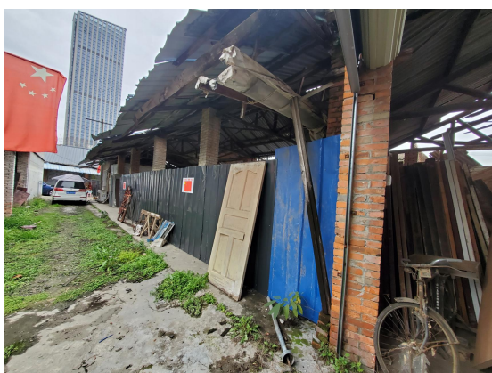
华阳木制厂库房（2025 年 4 月）
