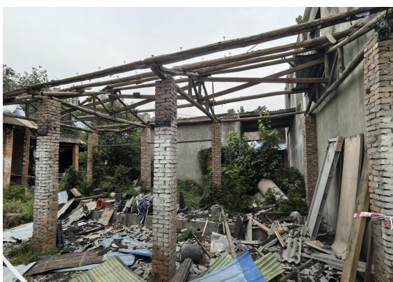
华阳木制厂晾干房（2025 年 4 月）
