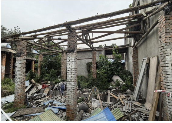
华阳木制厂晾干房（2025 年 4 月）
