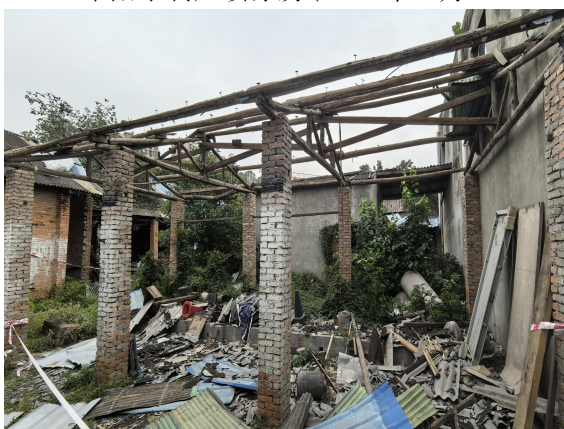
华阳木制厂晾干房(2025 年 4 月)
