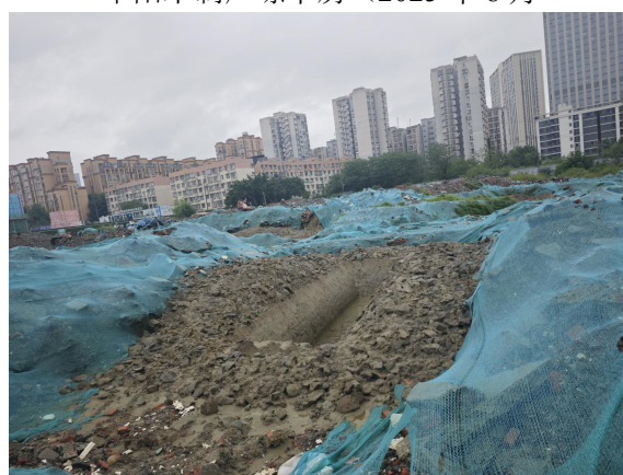
华阳木制厂喷漆房（2025 年 8 月）
