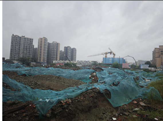
华阳木制厂库房（2025 年 8 月）
