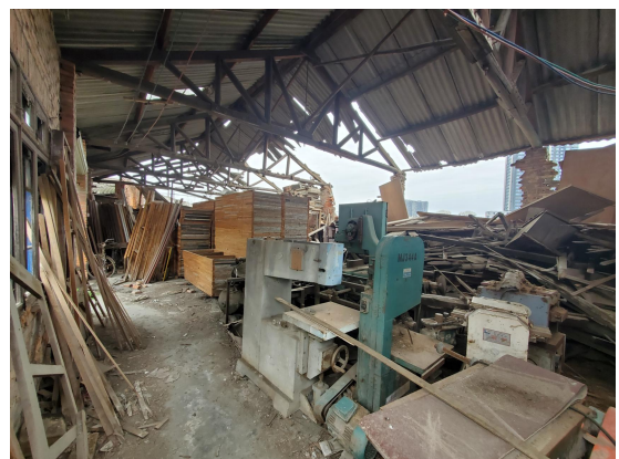
华阳木制厂库房（2025 年 4 月）
