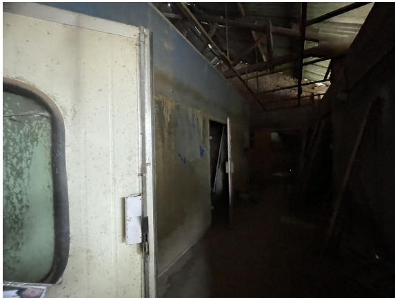
华阳木制厂喷漆房（2025 年 4 月）
