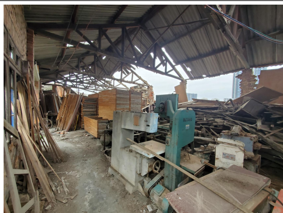
华阳木制厂库房（2025 年 4 月）
