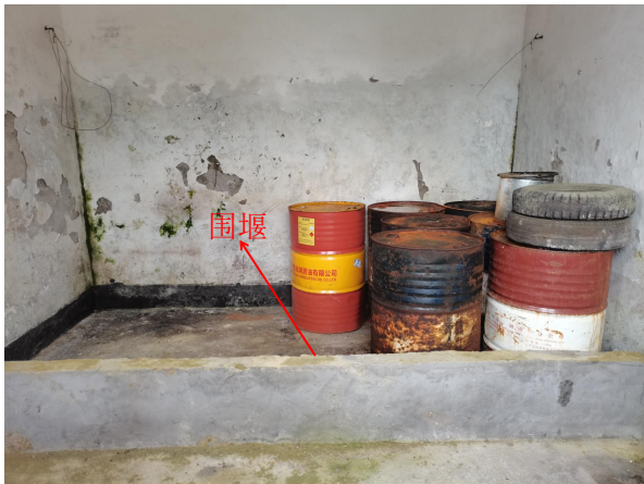
危废暂存间（废机油）
