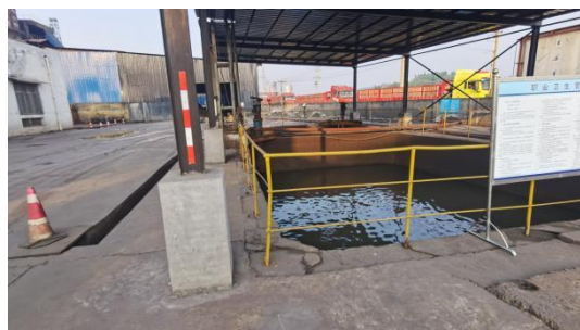
污水收集池（用于地坪冲洗水的收集回收，同时兼做事故应急池）
