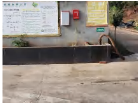
采气废水进水口
