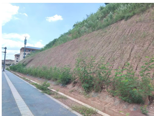
地块内东侧边坡
