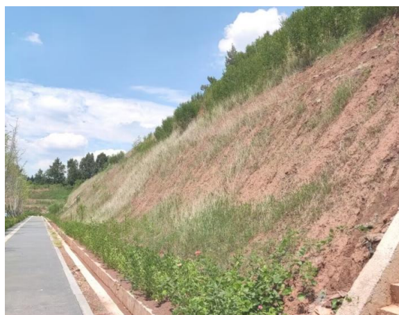
地块内南侧边坡区域
