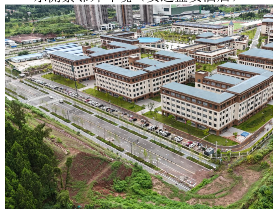
南侧紧邻外环境（四川省资阳市安岳县安岳县实验中学（城南新校区））
